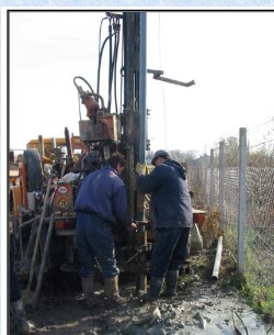
Слика 10. Уградња пиезометарске конструкције у астропузи
